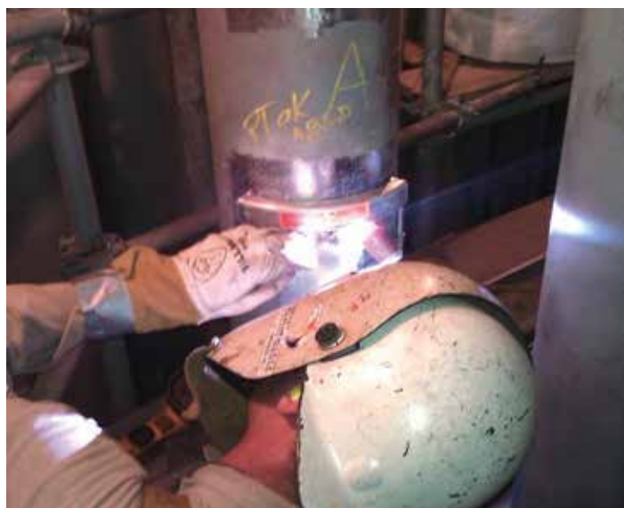
Квалифицированный специалист, выполняющий монтаж термопары для измерения температуры поверхности трубы
